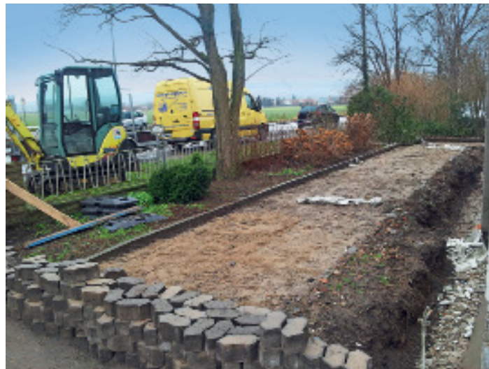
An der Fassade (li.) gab es eine Menge zu tun: Der Putz wurde entfernt und eine neue Isolierung aufgebracht. Gut zu erkennen: der Niveauunterschied zum Gelände, der in der Folge angepasst wurde (re.). Abschließend konnte das Gelände gepflastert werden.
