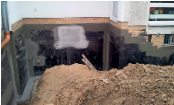
Die freigelegten Außenwänden wurden abgedichtet.
